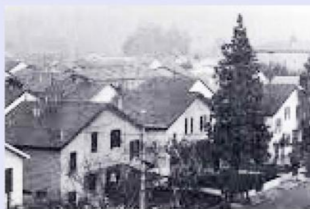
Le prime costruzioni al Villaggio Violino
