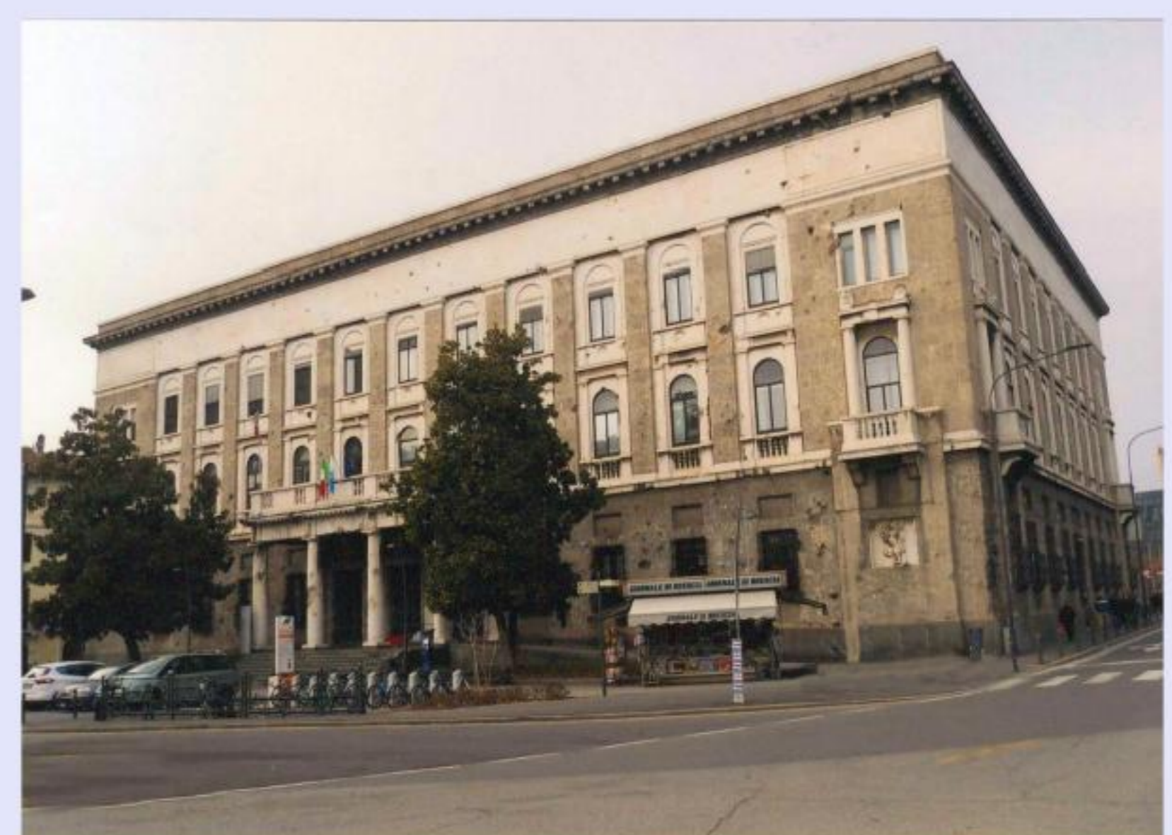
Brescia, Casa dei lavoratori
