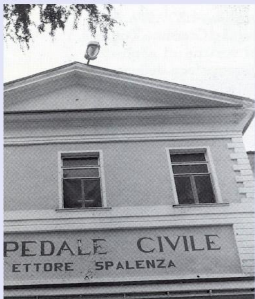
Rovato, facciata principale dell'Ospedale E. Spalenza
