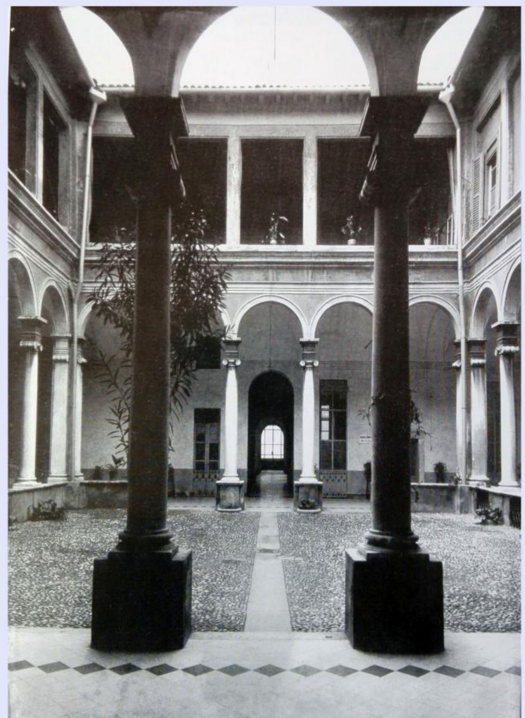
Il cortile dell'Ospedale degli Incurabili, in una veduta da sud verso nord nelle condizioni originarie
