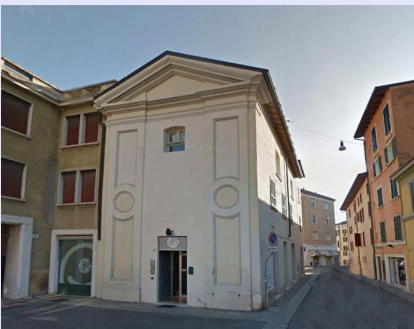
Brescia, Chiesa di Santa Maria della Mansione. Lo stato attuale della chiesa e della piazzetta antistante. Fino al 1769 l'edificio arrivava al margine della strada
