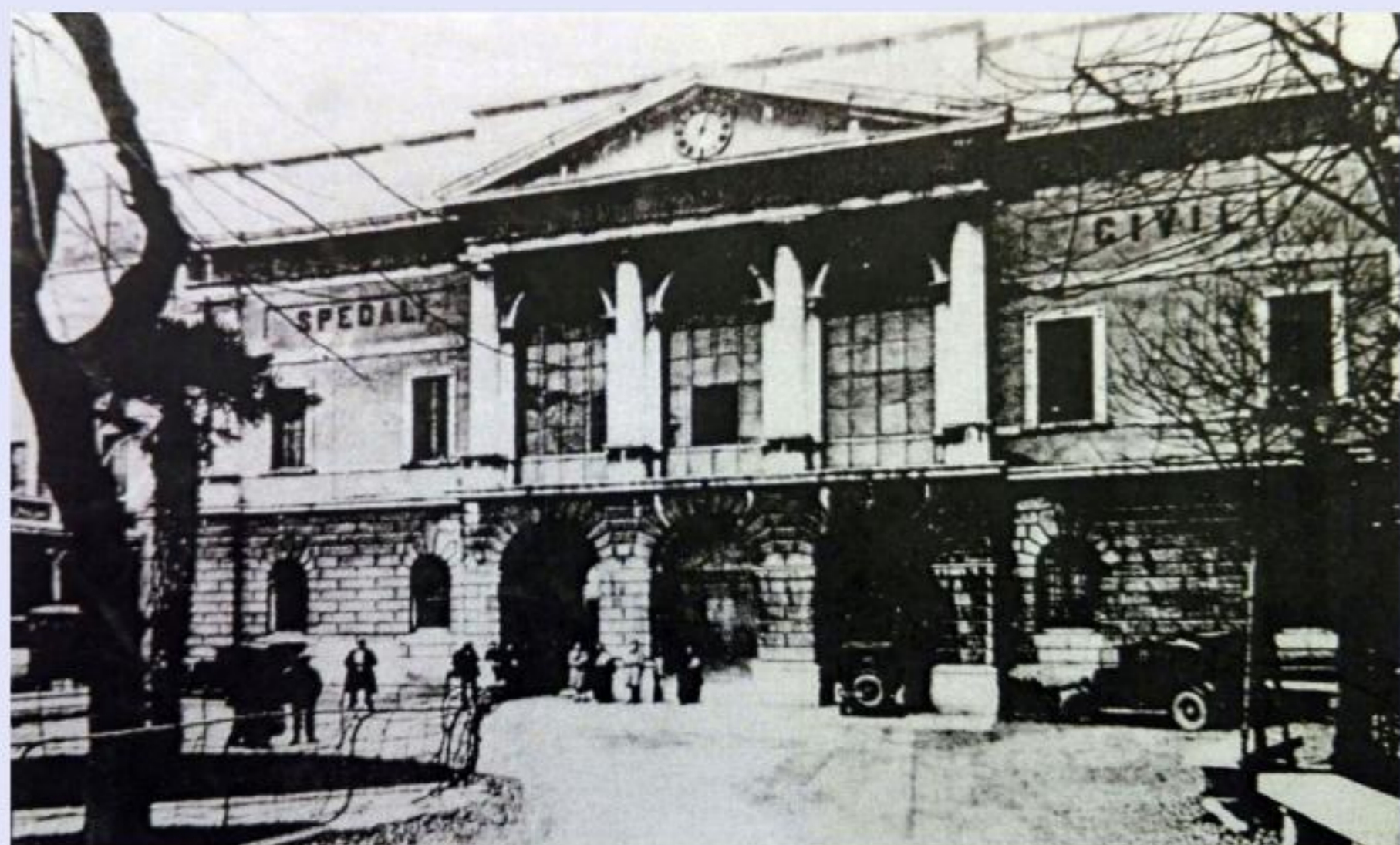
Facciata degli Spedali Civili nella piazzetta di San Domenico in via Moretto. L'Ospedale venne demolito negli anni Sessanta del Novecento
