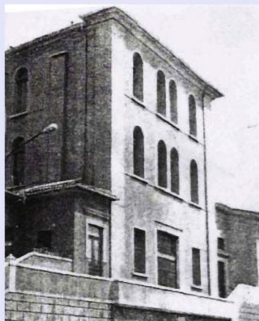
Chiesa di S. Giustina: la facciata ricorda l'ingresso della chiesa successivamente adibita a palestra
