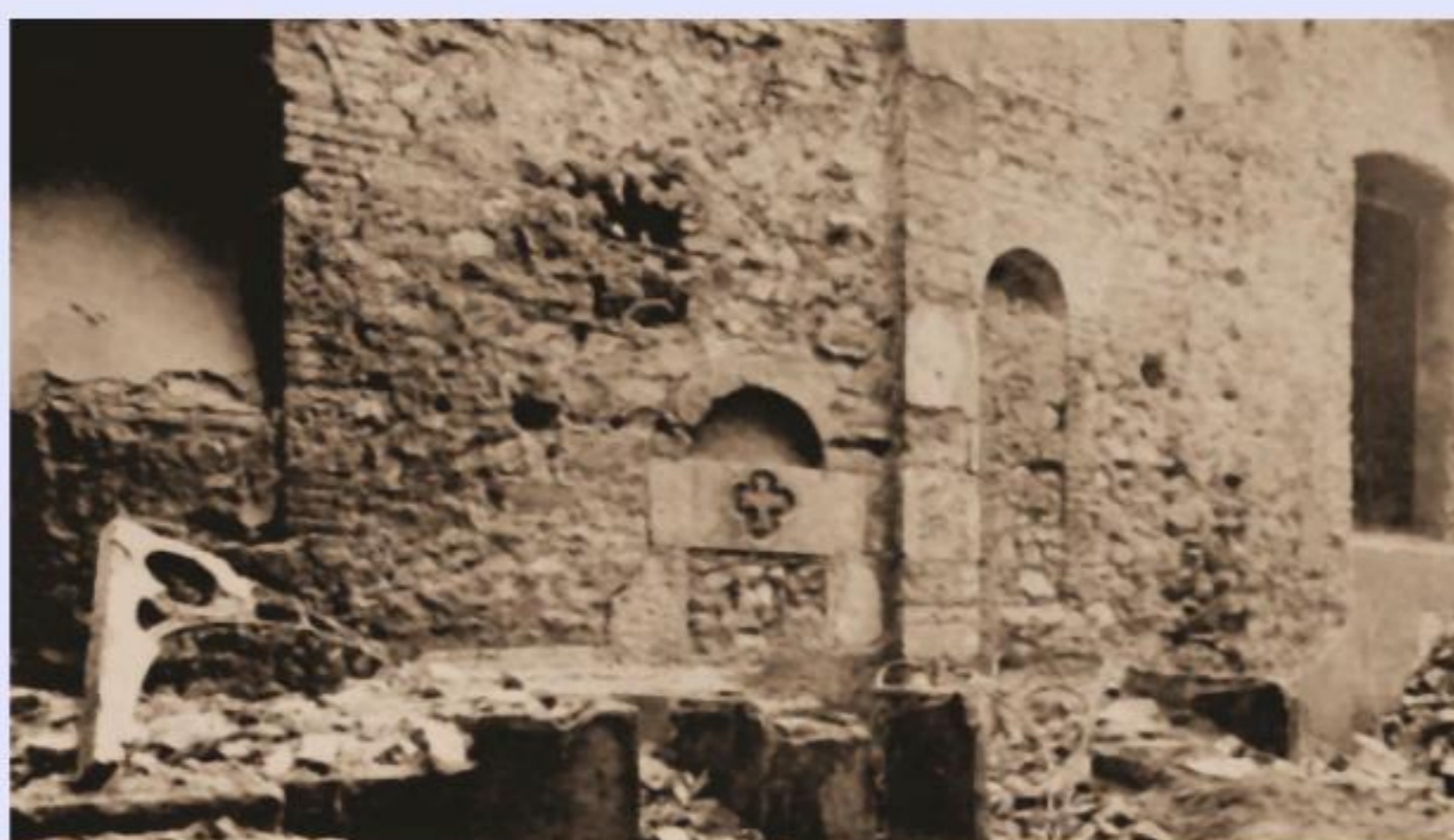
Facciata della chiesa antichissima di S. Ambrogio. Si trovava dove ora è il cosiddetto Quadrilatero di piazza Vittoria e dava il nome ad una via. Durante la demolizione si rivelava la straordinaria stratificazione di questa architettura che poggiava su pietre romane. (Direzione Musei di Brescia)
