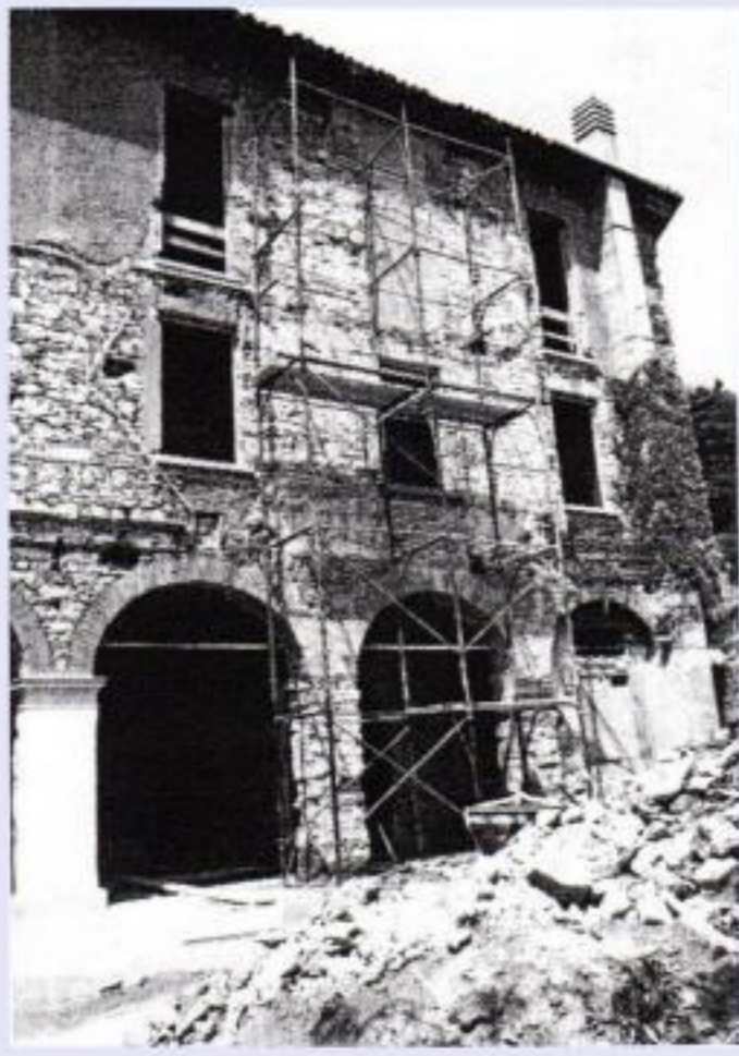
1990: il dormitorio in ristrutturazione
