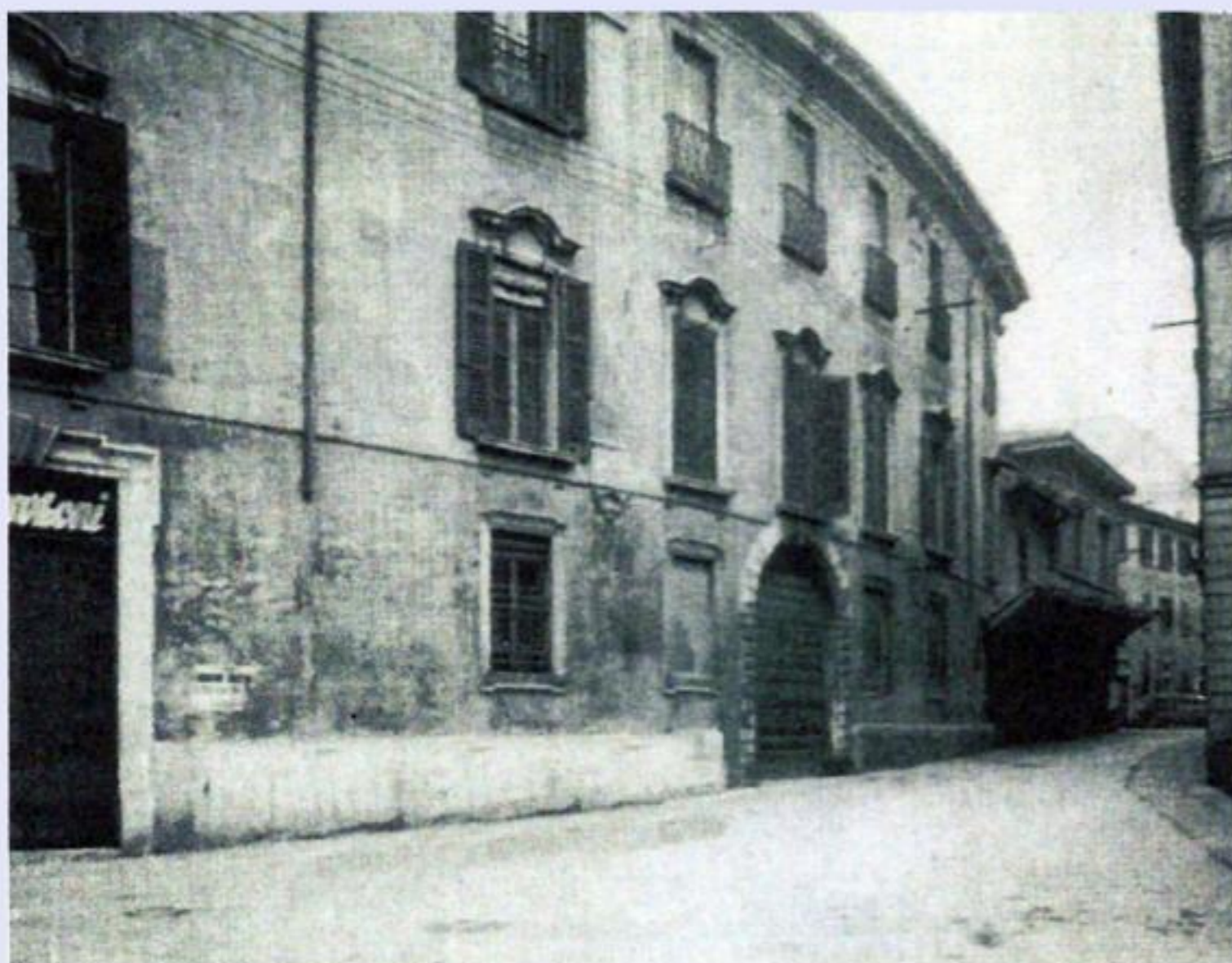
L'imbocco di via Tosio da ovest, con il vecchio palazzo S. Paolo, prima delle demolizioni
