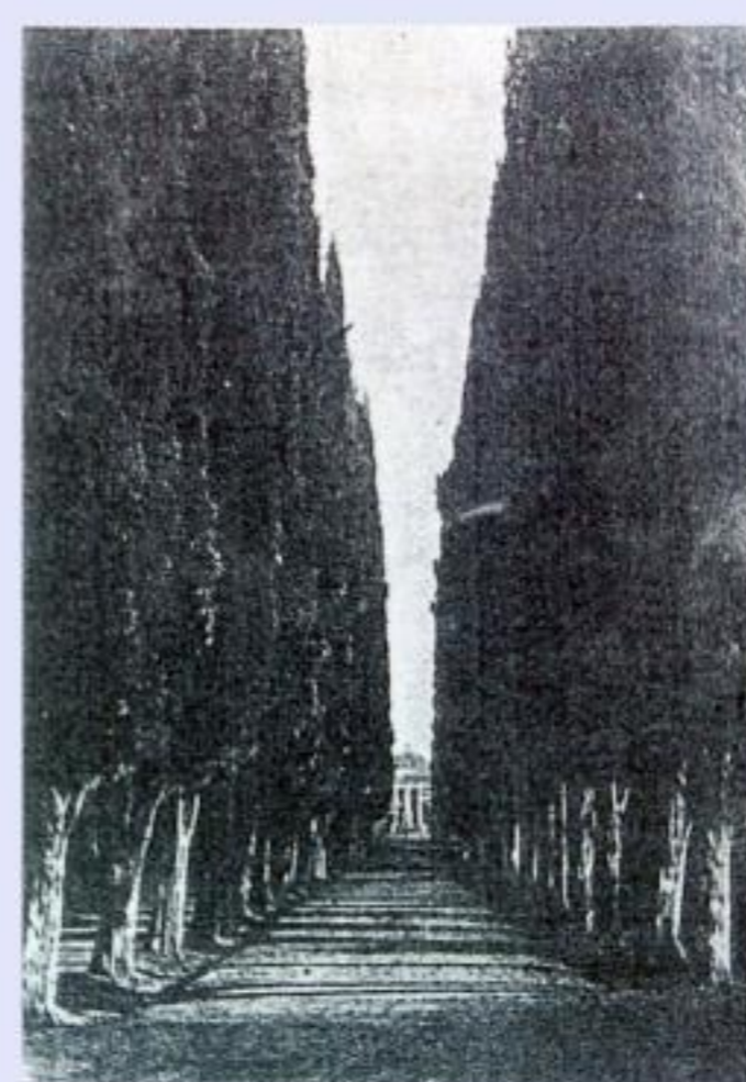
Il vecchio viale del cimitero inaugurato con la Cappella Isonni nel 1880.
