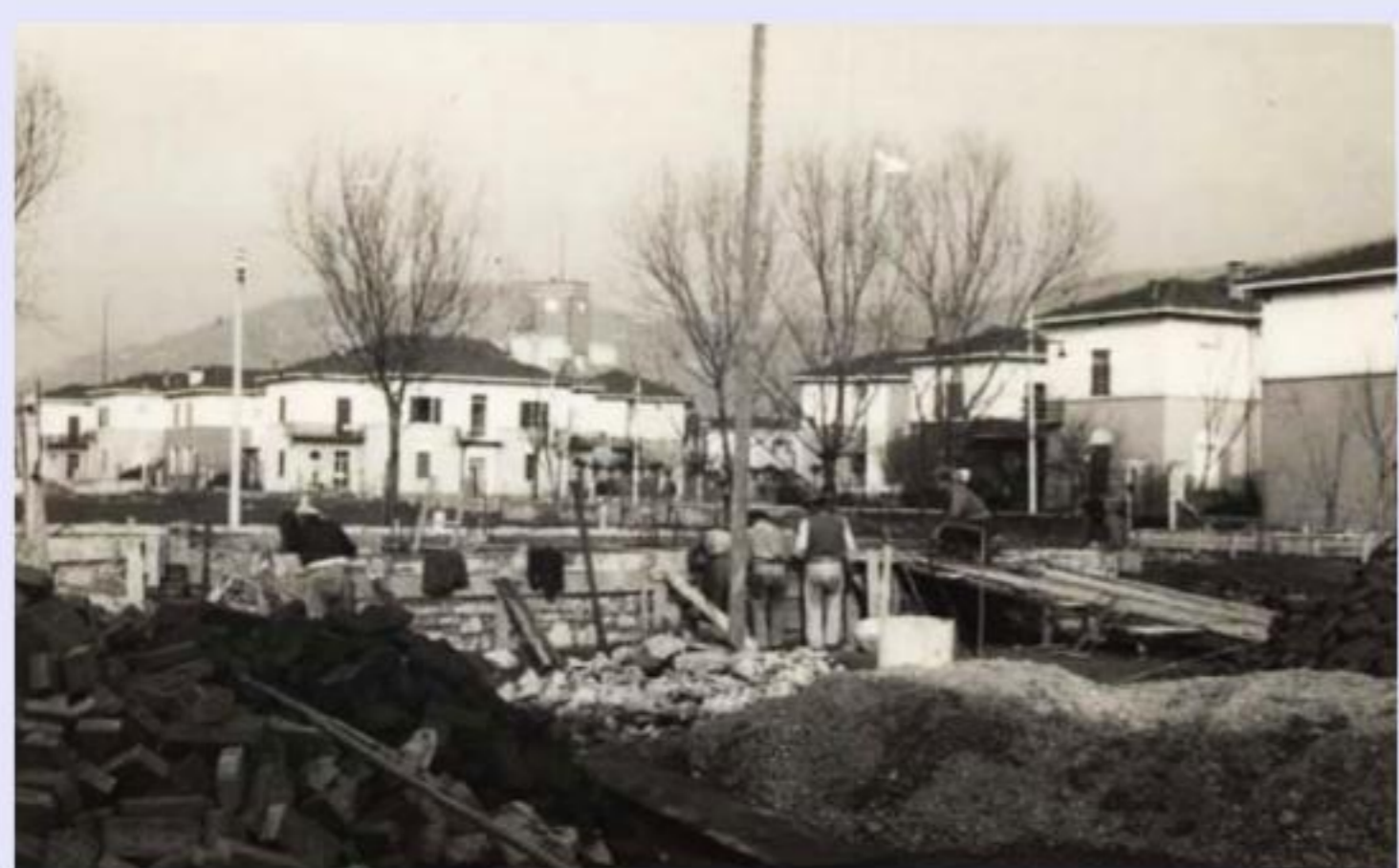
Brescia, febbraio 1951. Costruzione del villaggio "S. Antonio" per i profughi giuliani (Collezione Privata Comm. Antonio Cepich).
