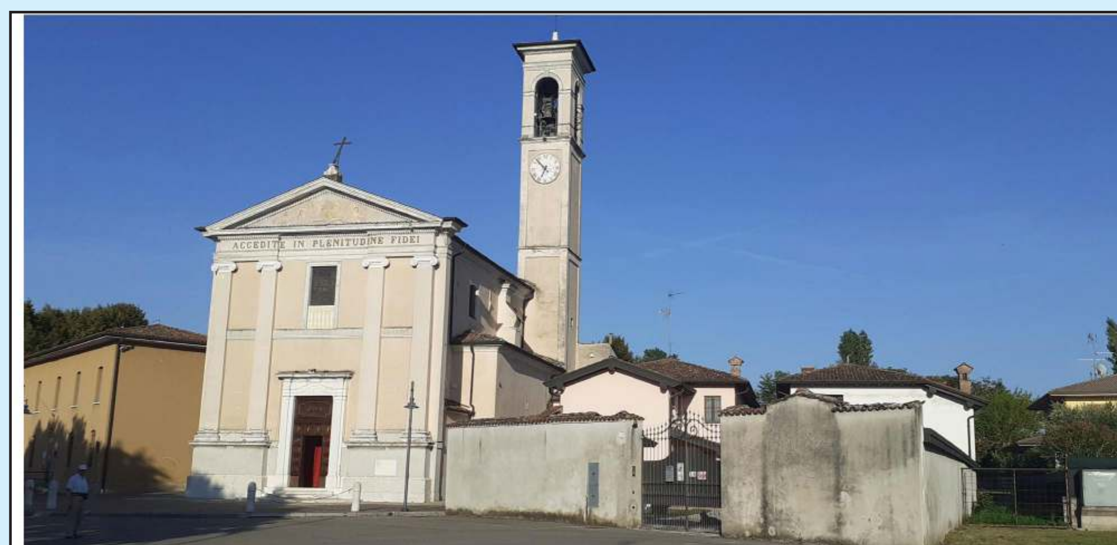
Da sx: le scuole elementari, la parrocchiale, la canonica e le stanze del curato, ora ristrutturate (foto Micheletti)
