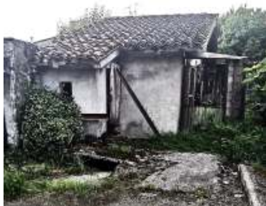
Questa struttura non ancora demolita fungeva da servizi igienici. Dietro si trovavano la porcilaia e la vasca del letame
