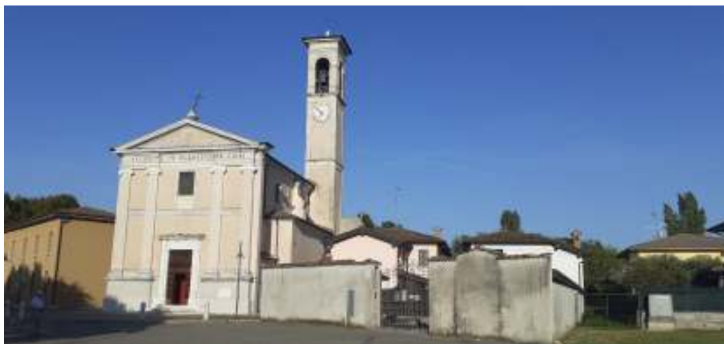
Da sx le scuole elementari, la parrocchiale, la canonica e le stanze del curato, ora ristrutturate (foto Micheletti)
