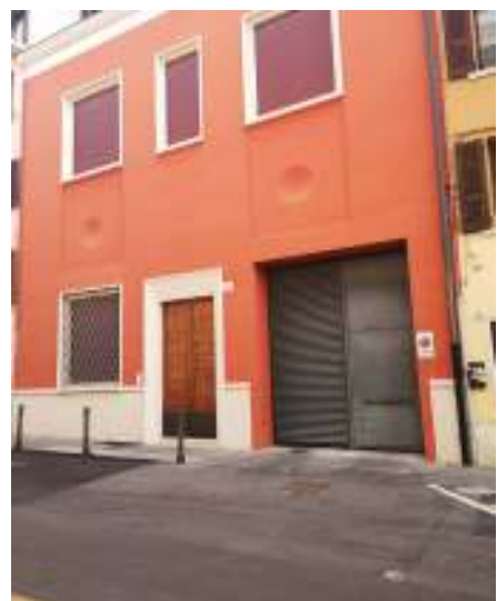
Via A. Monti 9, dove si trovava il museo di Arte e Spiritualità. Oggi l'edificio è stato ristrutturato
