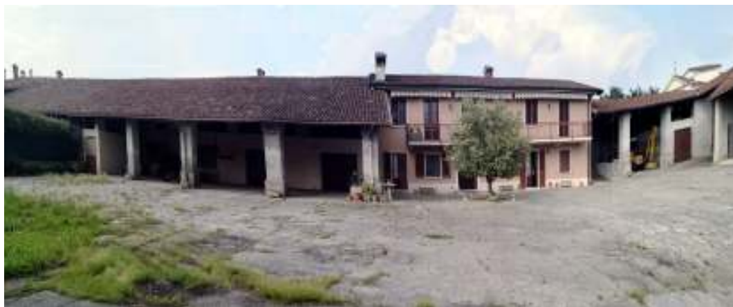
La cascina Fappani oggi. Sulla sinistra la stalla e a destra l'abitazione, in parte ristrutturata
