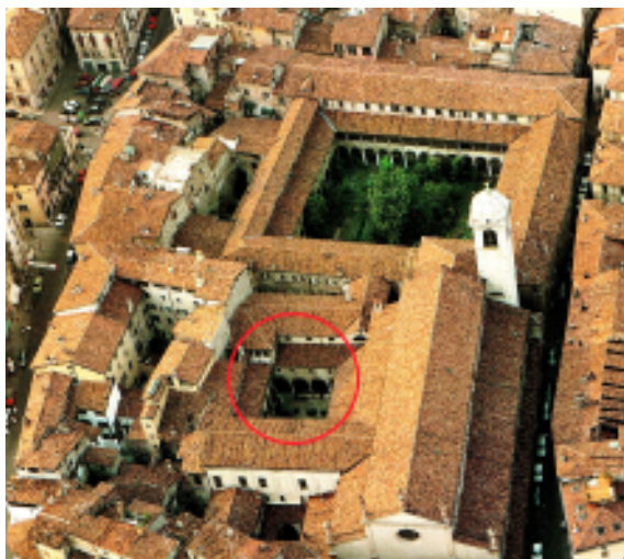
La Fondazione Civiltà Bresciana occupa i locali al primo piano prospicienti il secondo chiostro del convento di S. Giuseppe
